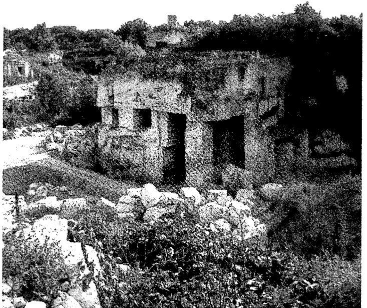
Vue d'ensemble sur la carrière à ciel ouvert de Prignac-et-Marcamps (33). (Cl. Thierry MAUDUIT)
